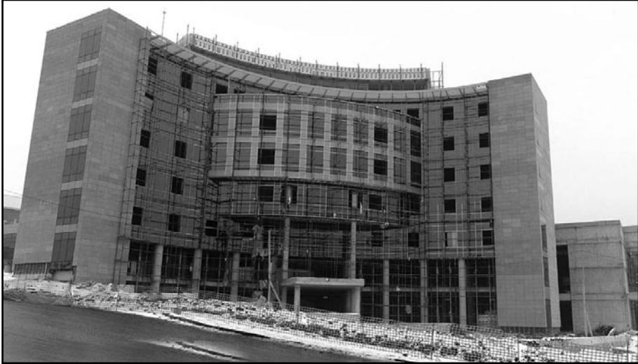
TBB hizmet binası inşaatı hızla ilerliyor (Ocak 2008).
